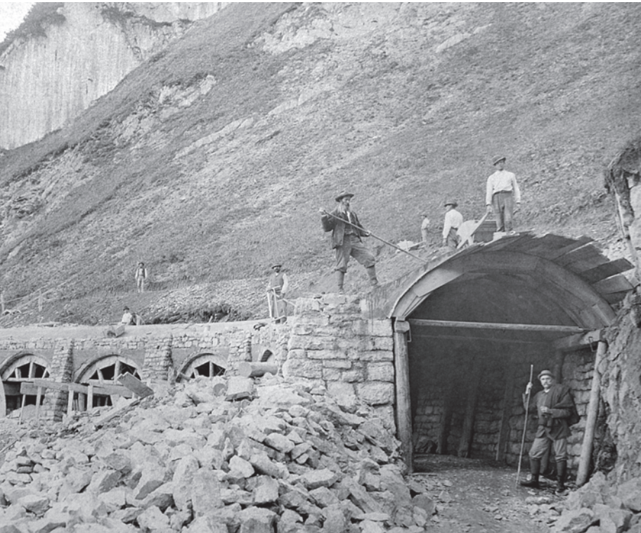
Baumeister-Karriere bei schwierigen Verkehrsbauten wie der Flexenstraße (1896) ...
