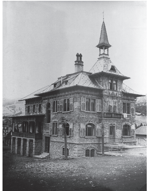
... und bürgerliche (historistische) Fassaden (Bahnhofsrestauration Egg 1909 – in den 1980er Jahren abgerissen)
