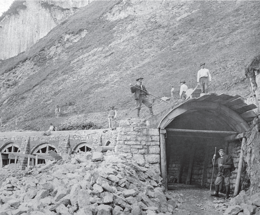
Baumeister-Karriere bei schwierigen Verkehrsbauten wie der Flexenstraße (1896) ...
